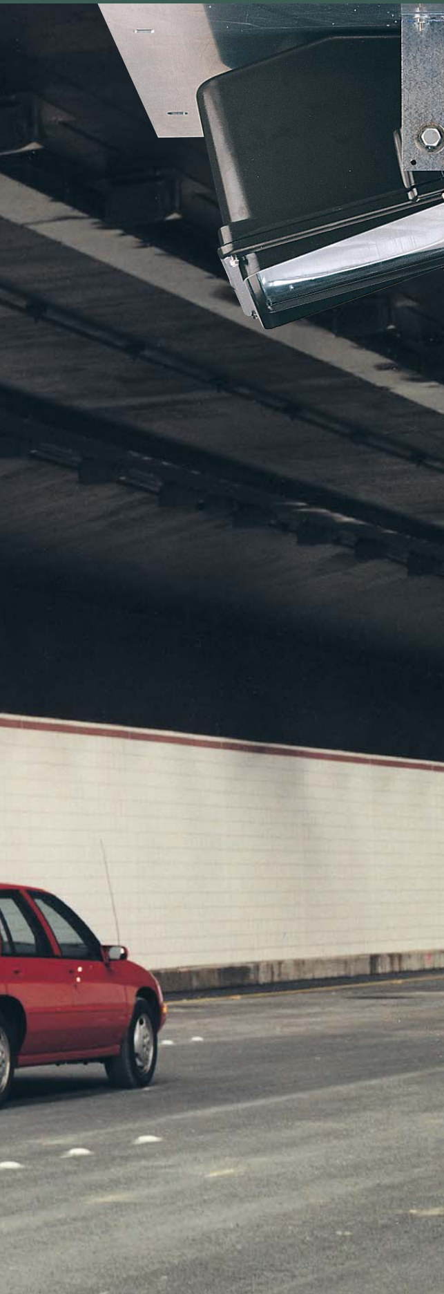
McCarron Tunnel; Las Vegas, Nevada
